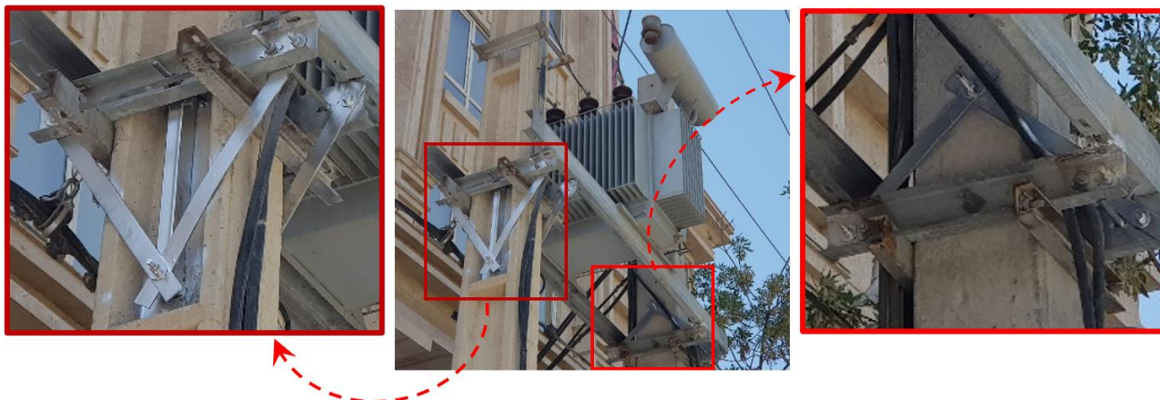
شکل ۱۷. نمای شمال غربی پست هوایی مقاوم سازی شده
