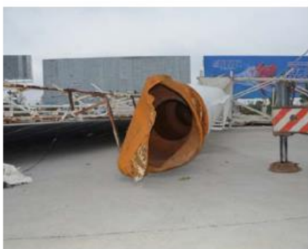
(د) گسیختگی پای ستون فولادی
