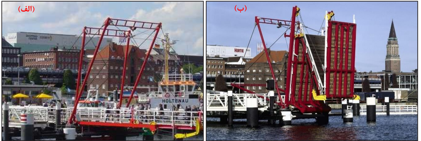
شکل ۱. (الف) پل هورن آلمان در وضعیت بهره‌برداری - (ب) پل هورن آلمان در وضعیت بسته
