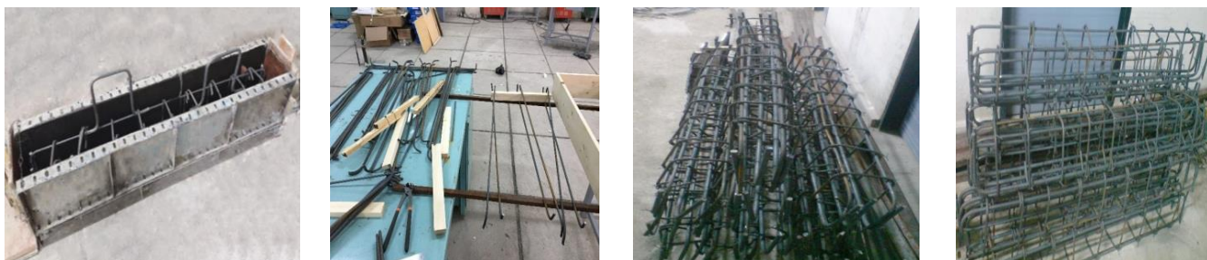
شکل ۸. نحوه بستن شبکه آرماتور و آماده‌سازی و روغن‌زنی قالب‌های فلزی
