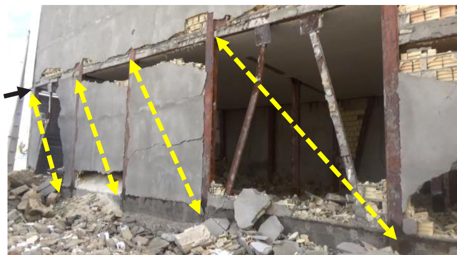
شکل ۴. تحمل بخشی از بار جانبی از بار جانبی از طریق شکل گیری دستک قطری فشاری دیوار پرکننده (نگارندگان)
