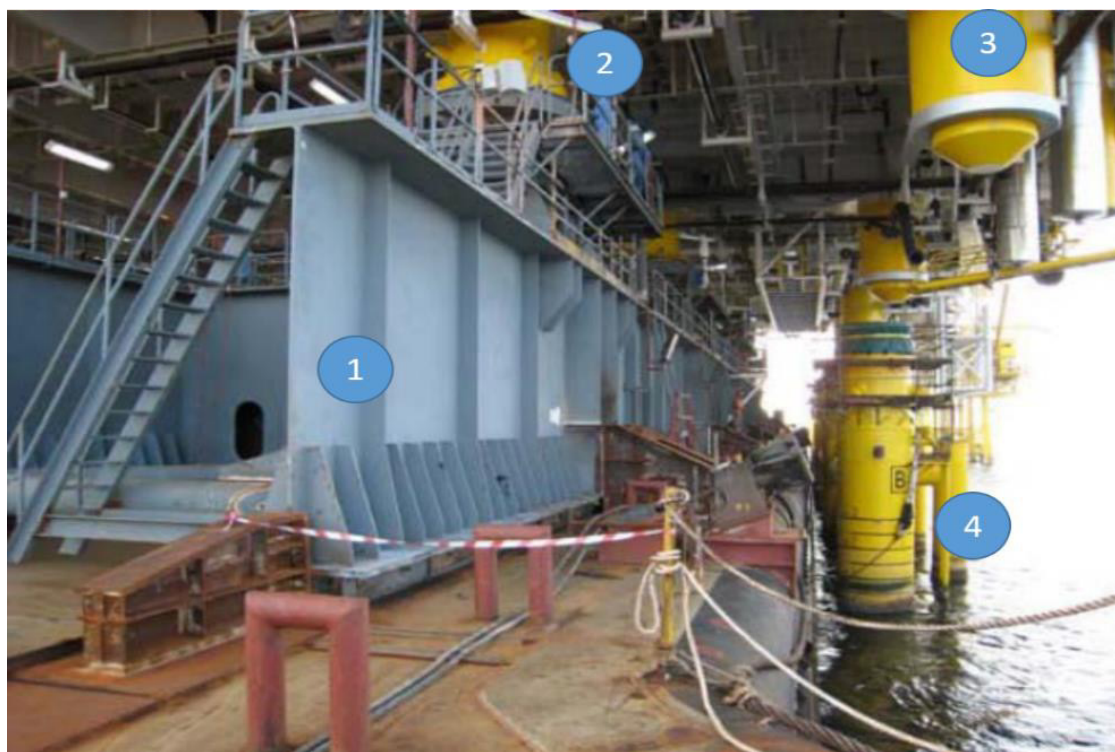
شکل ۱. المان‌های مورد استفاده در نصب فلوت‌اور، (۱) سازه نگهدارنده عرشه، (۲) المان نگهدارنده عرشه، (۳) المان میتینگ، (۴) پایه‌های جکت [۲۰]
