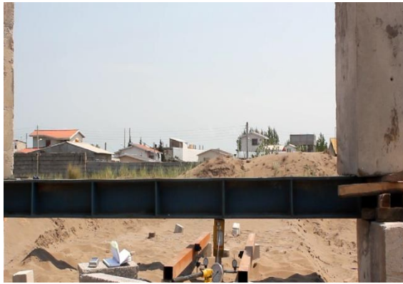
شکل ۱. اعمال بار فشاری با استفاده از جک هیدرولیکی و گیج‌های اندازه‌گیری نشست
