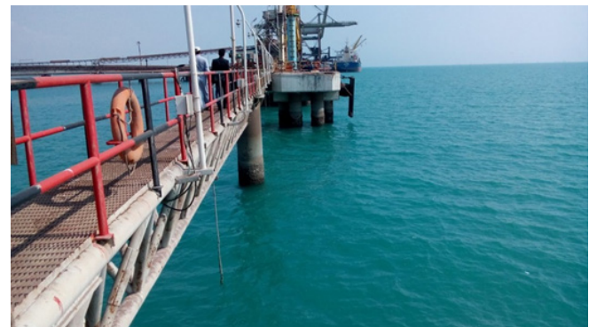
شکل ۲. نمای بخش شرقی اسکله فولاد Fig 2. The view of east side of steel wharf
