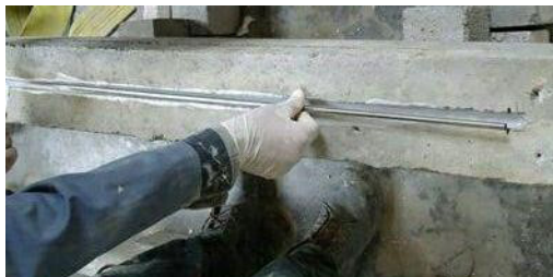
شکل ۳. قرار گرفتن مصالح مقاوم کننده درون شیار
