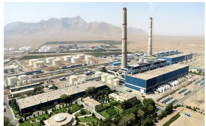
شکل ۲. نمایی از دودکش‌های نیروگاه شهید منتظری اصفهان Fig. 2. An upper view of the Montazeri Power Plant
