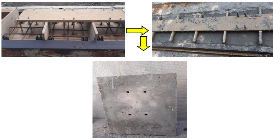
شکل ۴. نحوه ساخت دال بتنی پیش ساخته.
