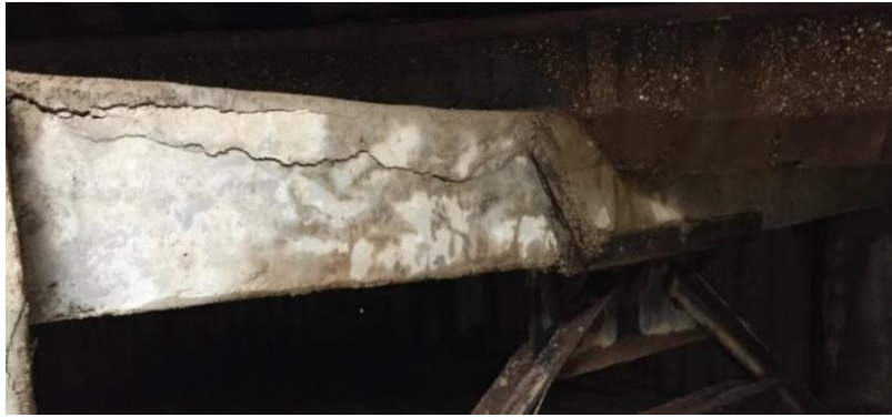
شکل ۶. نمایی از یکی از تیرهای سازه در تراز +۱۱/۸۰ و ترکهای قابل رویت نسبتا عمیق.
