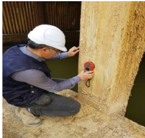
شکل ۱۳. نمونه‌ای از اندازه‌گیری پوشش بتن در ستون سازه.
