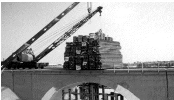
شکل (۲): بارگذاری استاتیکی پل کیلومتر ۲۳
