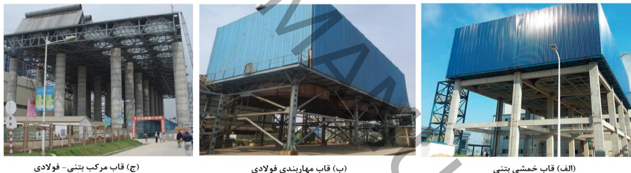
شکل ۱. انواع سیستم‌های سازه‌ای استفاده شده در سازه‌های نگهدارنده ACC نیروگاهی
