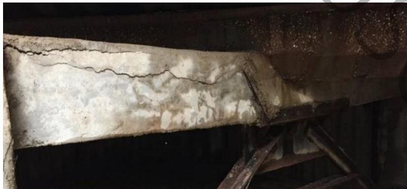
شکل ۶: نمایی از یکی از تیرهای سازه در تراز +11.80 و ترک‌های قابل رویت نسبتاً عمیق
