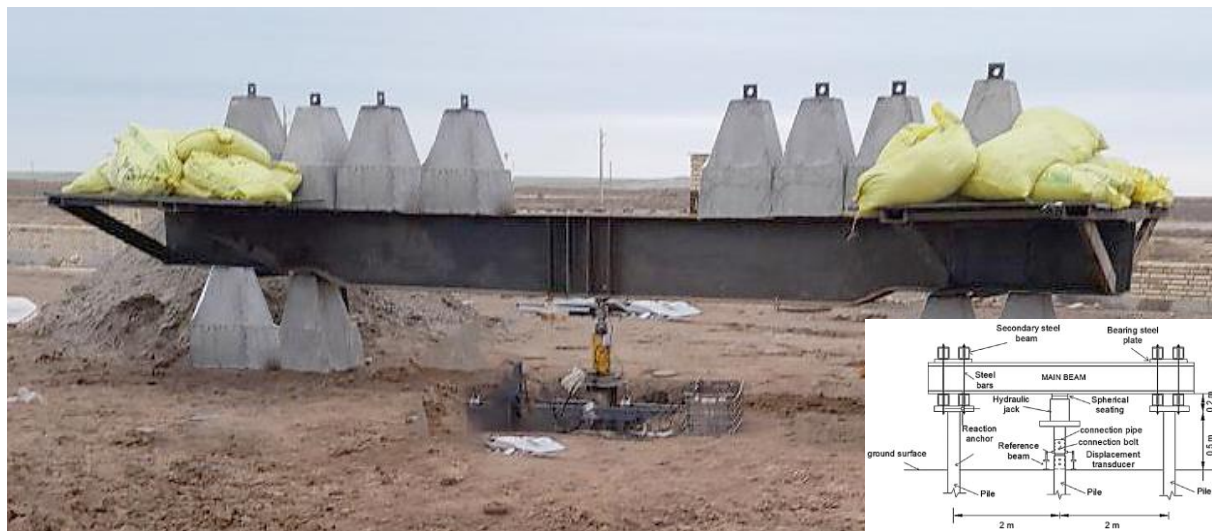
شکل ۹. انجام بارگذاری استاتیکی شمع پیچشی فشاری
