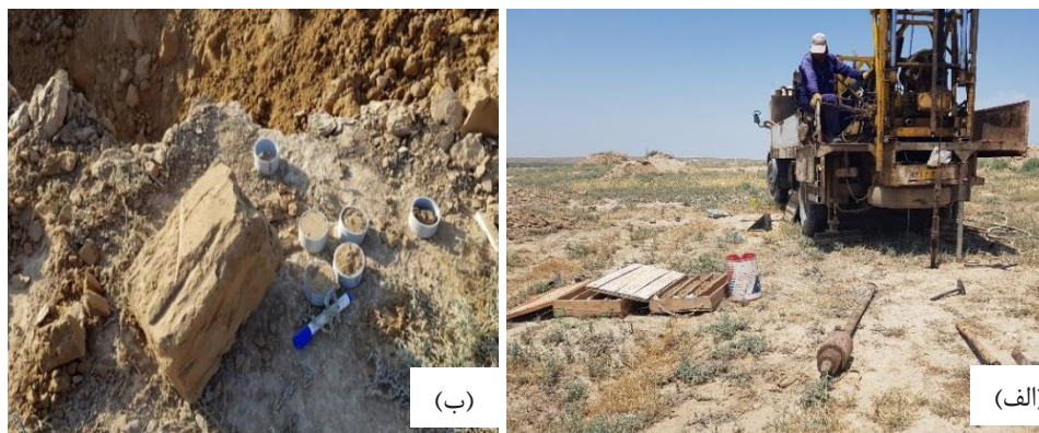
شکل ۳. الف) عملیات حفاری گمانه‌ها در منطقه داشلی برون، ب) برداشت نمونه بلوکی
