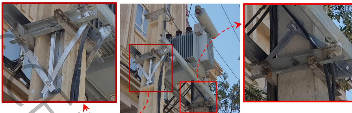
شکل ۱۷. نمای شمال غربی پست هوایی مقاوم سازی شده
