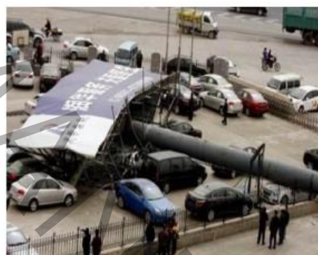
(ج) خرابی در بخش فونداسیون یا واژگونی سازه
