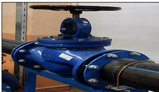
شکل ۳. شیر و مانیتور تنظیم‌کننده دبی جریان
