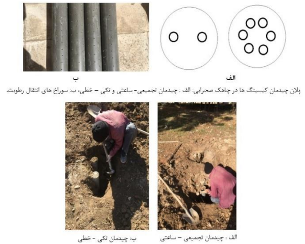
شکل ۵: راست: (شکل بالا) نحوه اجرای چیدمان نمونه ها و شرایط غلاف گذاری آنها در محیط صحرایی و (شکل پایین) استخراج نمونه ها از محل اختلاط صحرایی با چیدمان (الف) گروهی - ساعتی و (ب) تکی - خطی. چپ: ابعاد پلانی مدل ها.
