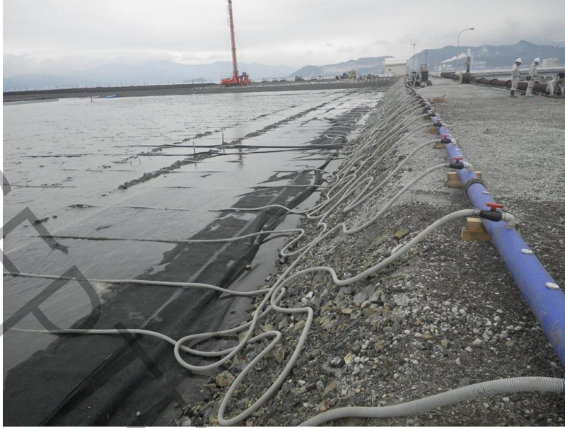
شکل ۱: پیش بارگذاری به وسیله بار سربار و بار خلاء [15]
