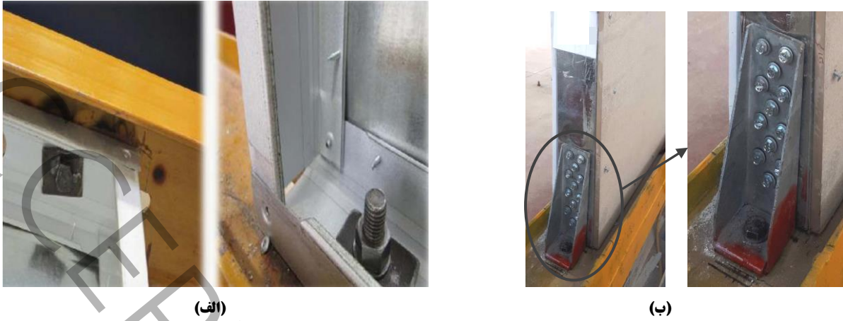
شکل ۵: الف - نمایش بولت‌ها. Error! Reference source not found. ب - جزئیات لچکی پای دو انتهای استادهای کناری
