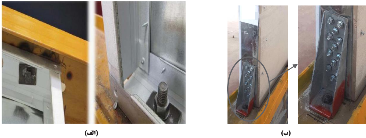
شکل ۵. الف- نمایش بولت‌ها [۱۲]، ب- جزئیات لچکی پای دو انتهای استادهای کناری
