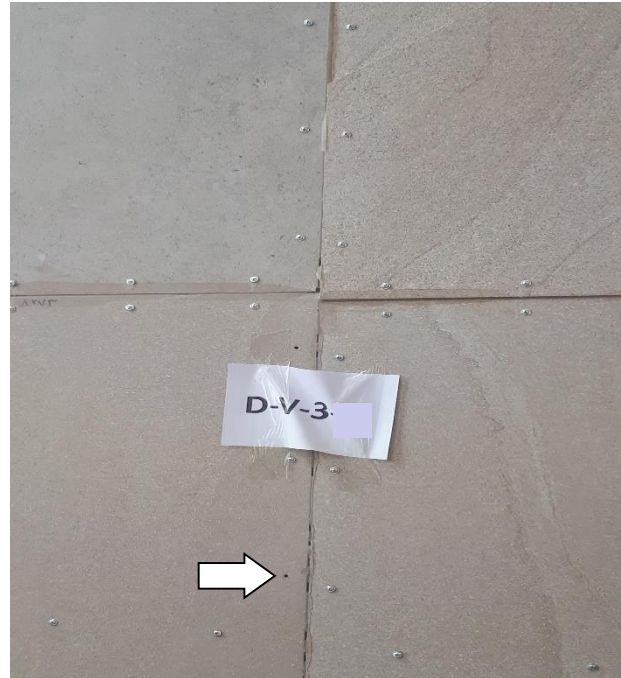
شکل ۱۲. نمایش ترک خوردگی‌های پوشش سرامیکی پرسلان، لهیدگی پای استاد و بیرون زدگی بیج اتصال پوشش با قاب
