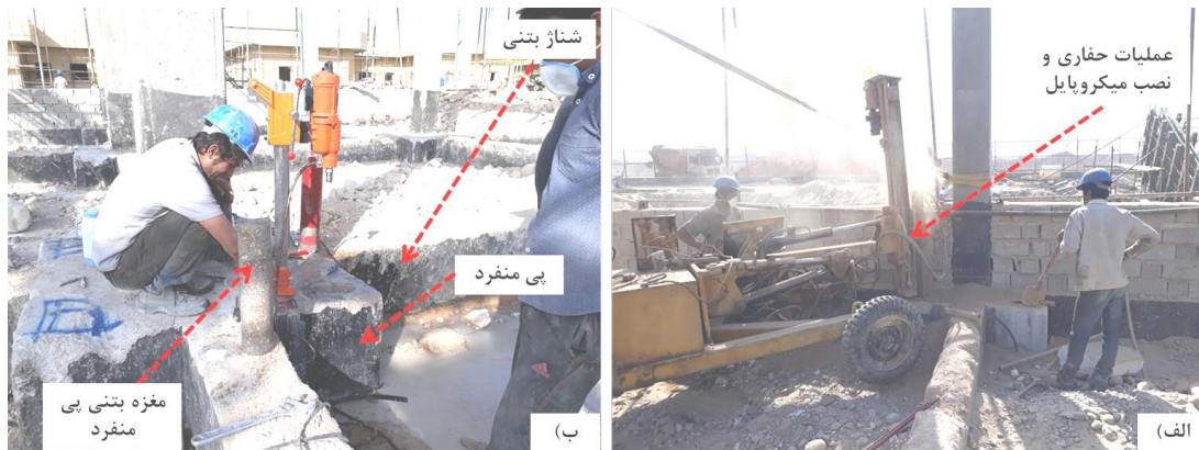
شکل ۴. انجام عملیات بهسازی خاک به روش ریزشمع، الف) حفاری و نصب ریزشمع، ب) مغزه گیری از پی
