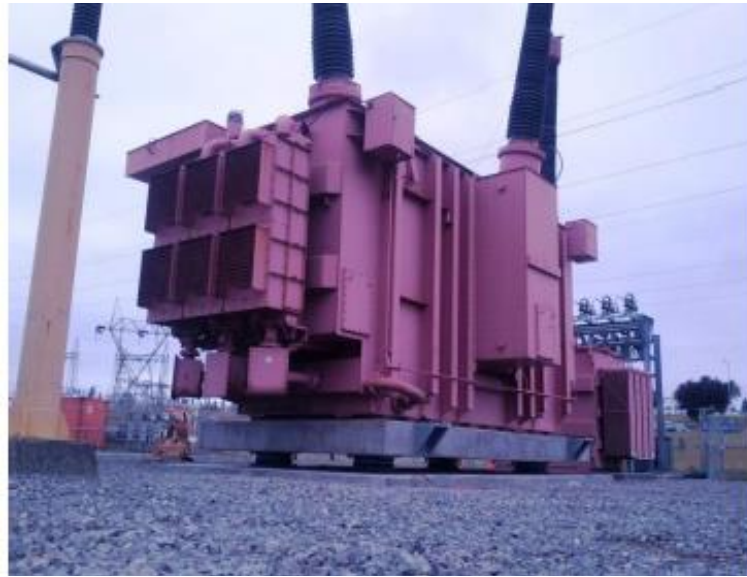
شکل ۵. ترانسفورماتور جداسازی شده فقط در جهت افقی در ونکوور [۳۹]
