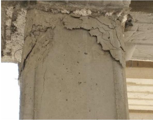
(ب) لایه لایه شدگی در بالای ستون بتنی ناشی از خمش b. Concrete cover spalling at top of the column due to flexure
