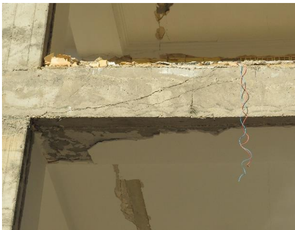
(ب) لایه لایه شدگی در بالای ستون بتنی ناشی از خمش b. Concrete cover spalling at top of the column due to flexure
