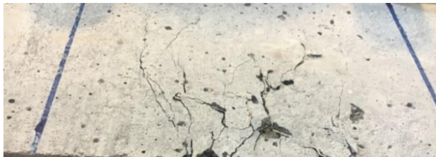
شکل ۷. پل زنی ترک
