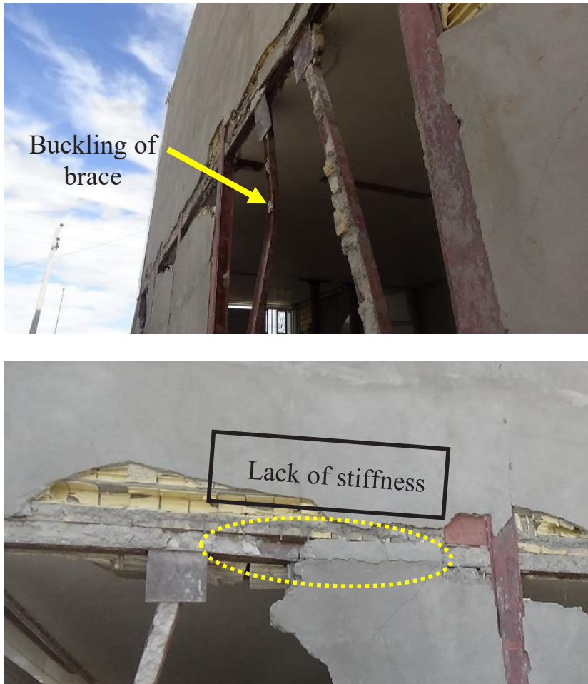
شکل ۳. (بالا) کماتش مهاربند برون محور به صورت برون صفحه، (پایین) عدم اجرای ورق سخت کننده در تیر پیوند (نگارندگان)
