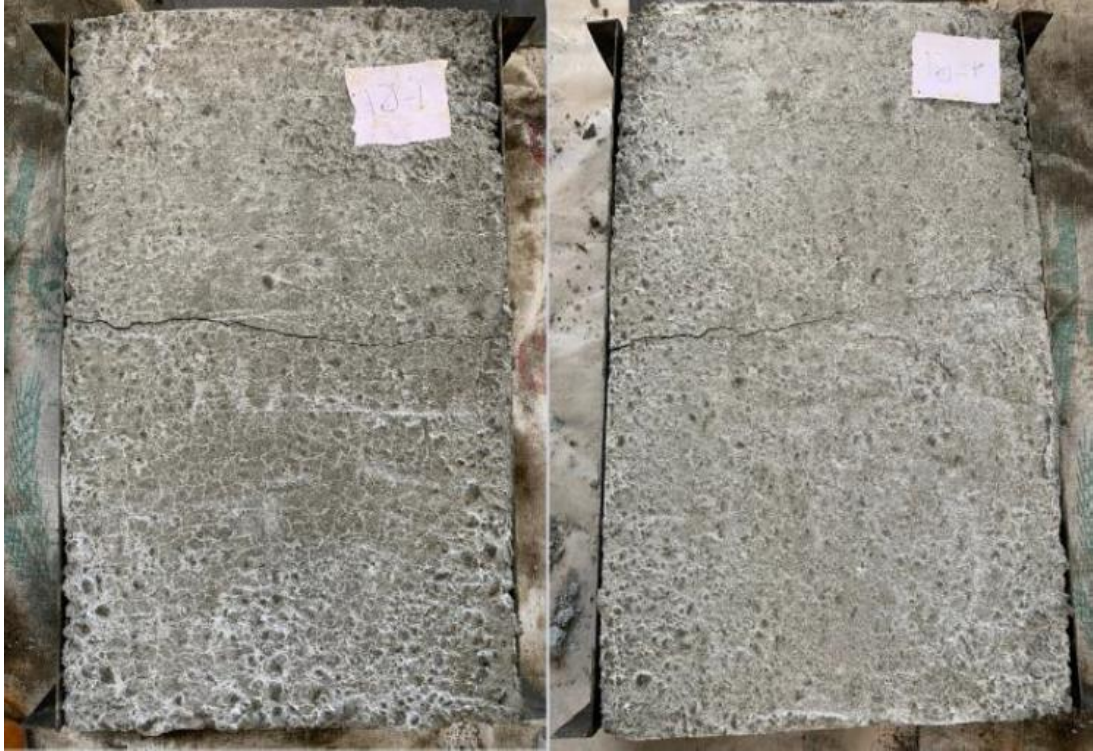
شکل ۸. نمونه‌های آزمایش شده دال بتن روسازی هوادار در انتهای آزمایش
