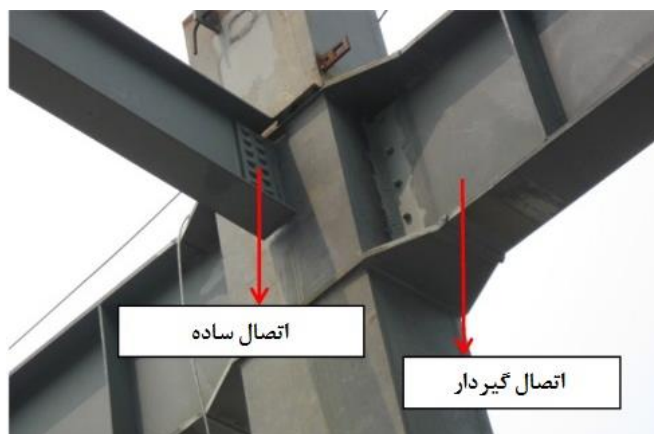
شکل ۳. اتصالات تیر فولادی به ستون فولادی پر شده با بتن (دو و همکاران ۲۰۱۷) [۶]
