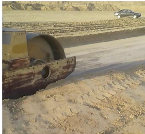
شکل ۳۱. نمایی از عملیات تراکم برای لایه‌های روسازی در محل سایت Fig. 31. Compaction performed on improved soil layers at the site
