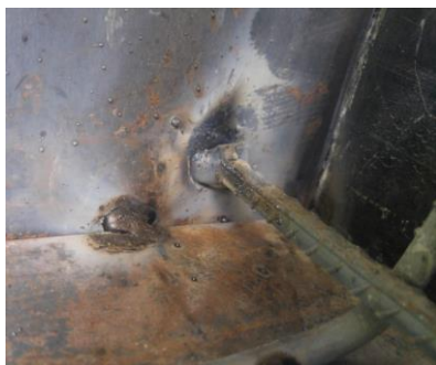
شکل ۹. ورق‌های تکیه‌گاهی دال‌ها Fig. 9. Slab's support sheets
