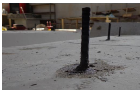
شکل ۱۳. کاشت مهارهای مکانیکی Fig. 13. Anchorage procedure
