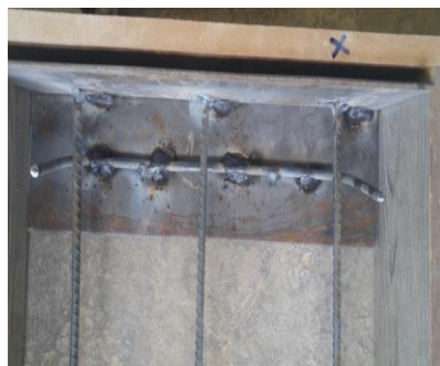
شکل ۹. ورق‌های تکیه‌گاهی دال‌ها Fig. 9. Slab's support sheets
