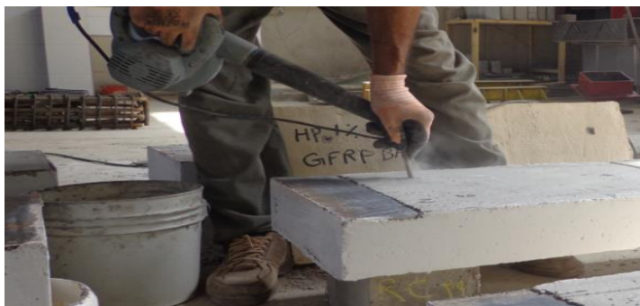
شکل ۱۲. تمیزکاری سوراخ‌ها از گرد و غبار Fig. 12. Cleaning the holes from dust
