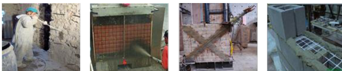
(الف) ژئوگرید [۹] (ب) FRP [۷] (پ) شاتکریت بتنی [۱۳] (ت) تزریق دوغاب ملات سیمان [۱۰]
