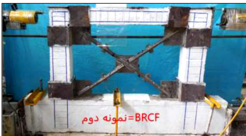
شکل ۲. روش اتصال مستقیم مهاربند فولادی به قاب بتن آرمه [۱۶] Fig. 2. Method of direct connection of steel brace to reinforced concrete frame
