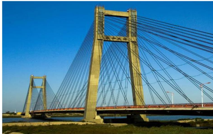
شکل ۳. نمایی از پل یونگ [۲۳] Fig. 3. View of Yonghe bridge [23]
