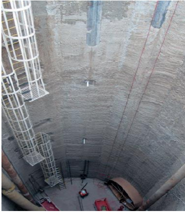
شکل ۲. دیواره‌های ساخته شده به روش برش و اختلاط خاک در عمق [۸]
